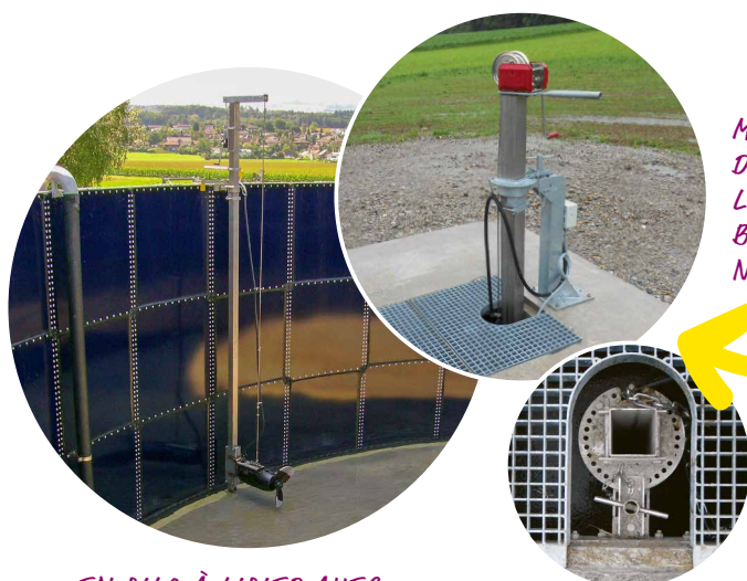
MONTAGE ENFOUI : LE MÂT PEUT ÊTRE RETIRÉ ET L'OUVERTURE, COUVERTE
